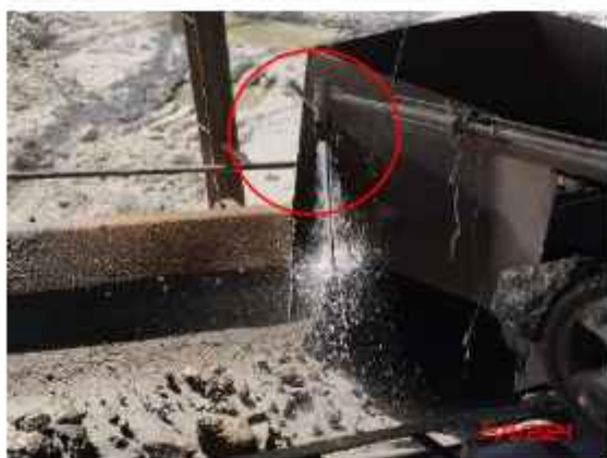
ระบบพ่นน้ำบริเวณแหล่งกำเนิดฝุ่นละออง
