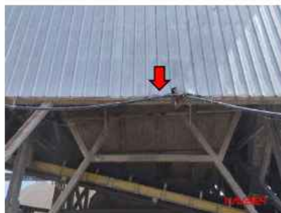
ระบบพ่นน้ำบริเวณแหล่งกำเนิดฝุ่นละออง
